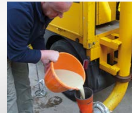
10 h 30 Début de pompage
