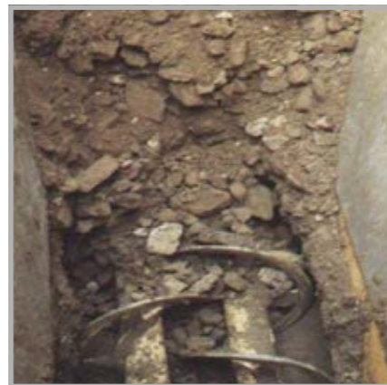
Lodos de tratamiento de aguas de refrigeración
