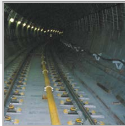
Trazado seguro de tuberías horizontales con Zentrifix®
