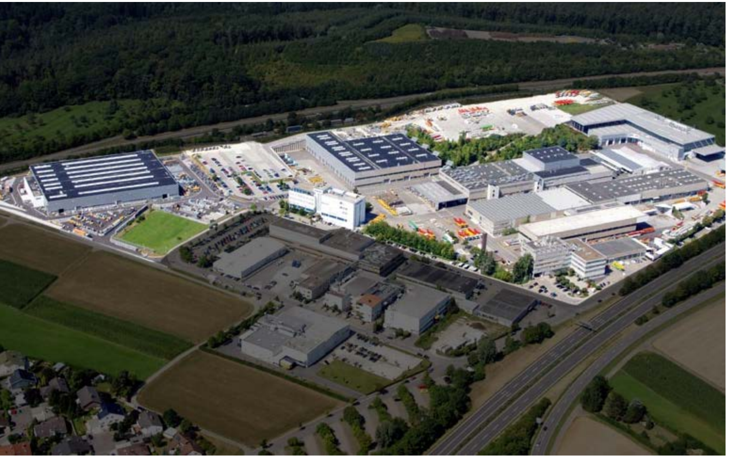
Cuartel general de Putzmeister en Aichtal
