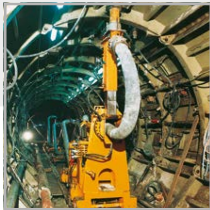
Hormigonado de túneles con tuberías flexibles SK utilizadas como tuberías de expansión
