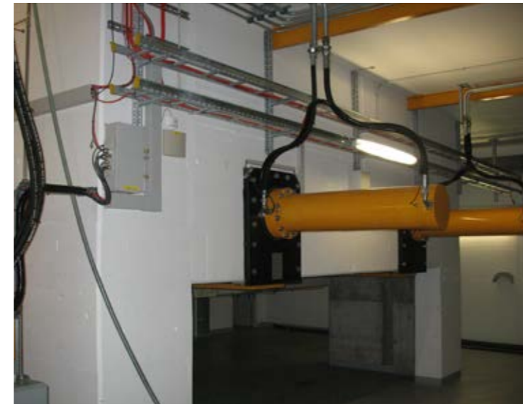
Cilindro hidráulico de marco deslizable en un silo de concreto, planta de tratamiento de aguas servidas Oftringen, Suiza
