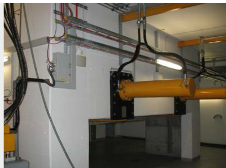
Цилиндр скользящей рамы в бетонном накопителе, Предприятие по очистке сточных вод в Офtringене, Швейцария
