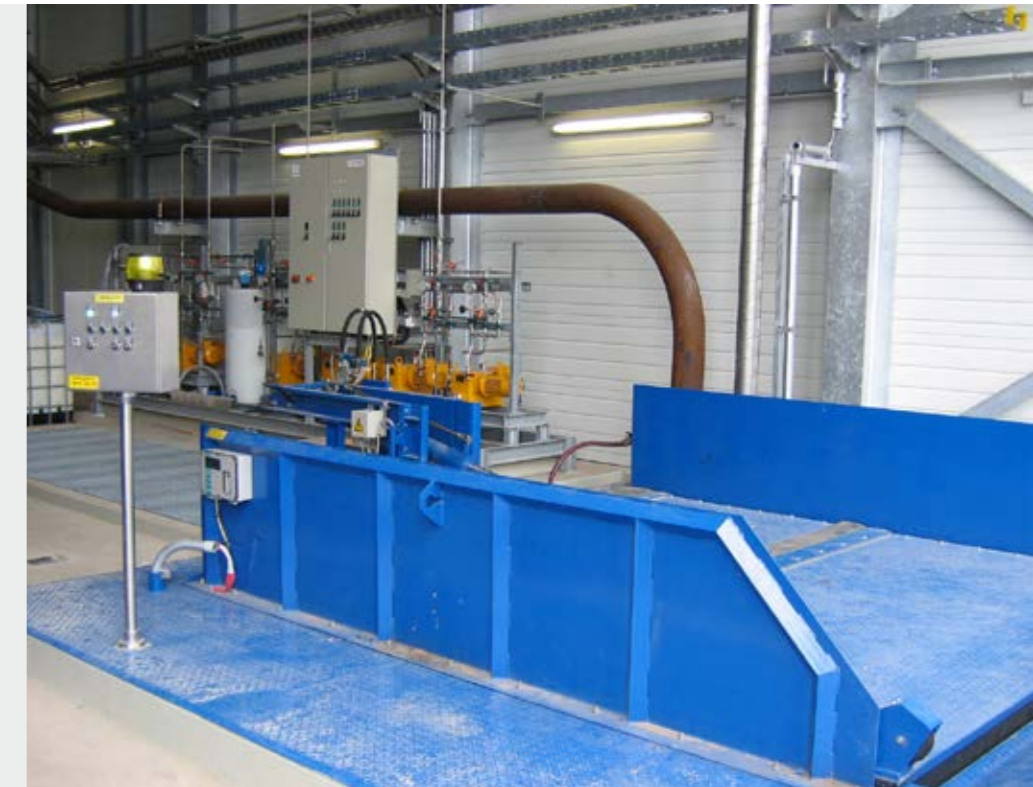
Вверху: Створки с автоматическим управлением являются важным элементом загрузочного бункера. Путцмайстер предлагает множество их типоразмеров.
