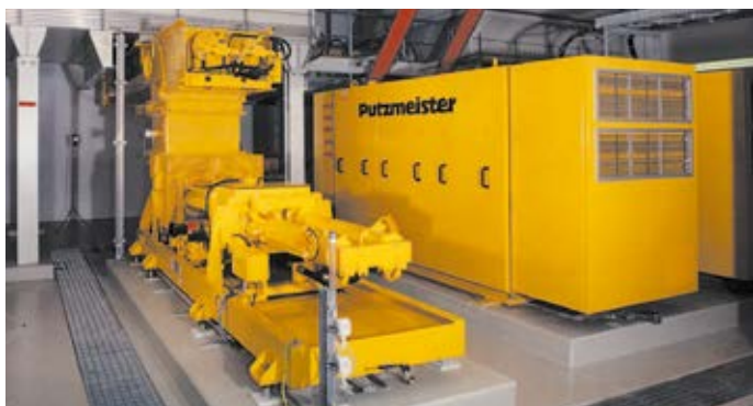
柱塞泵KOS2180用于在德国的Zolling燃煤电厂混合焚烧市政污泥
