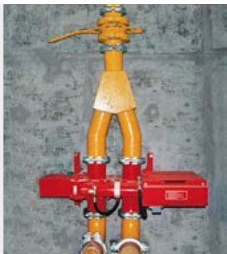
应用于焚烧厂的ZX150 IP管道系统
