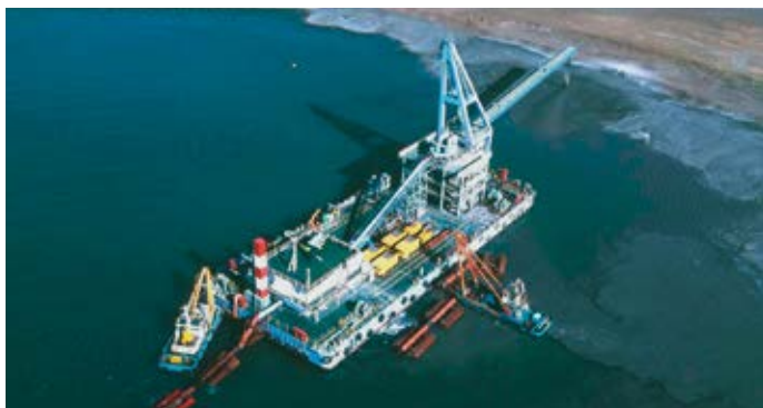
在日本海岸线前方的三台大型柱塞泵KOS25100和KOS25200将海里的淤泥泵送建设人工岛
