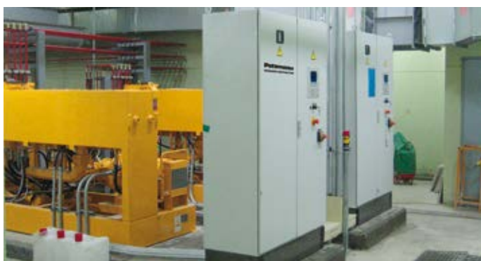
在韩国Gulpocheon污水处理厂的就地控制面板
