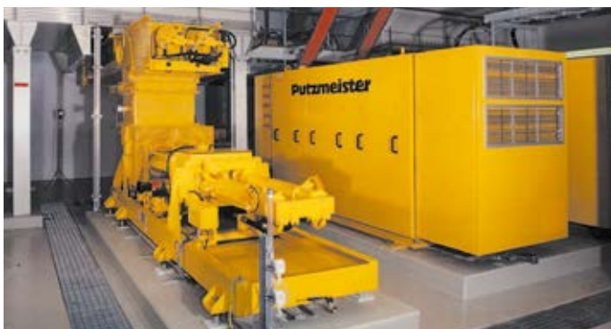
Попутное сжигание обезвоженного осадка водоочистных сооружений на угольной ТЭЦ Цоллинг (Германия) с помощью насоса по перекачке сгущённых масс типа KOS 2180
