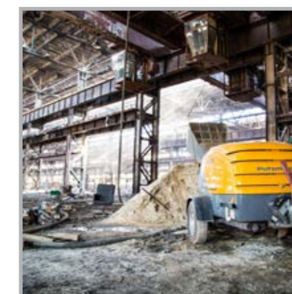
Russland, Ryazan ~ 100 000 m 2 Estrich verlegt
