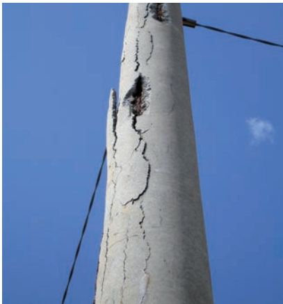
Abb. 17/18: Abplatzen der Betondeckung durch Bewehrungskorrosion (starke Meersalzbelastung)
