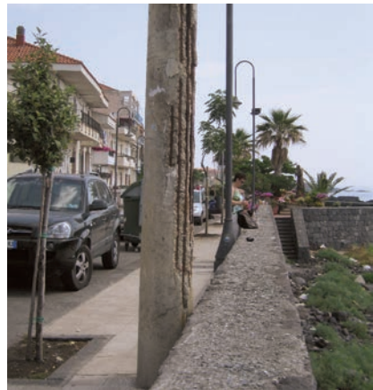
Abb. 17/18: Abplatzen der Betondeckung durch Bewehrungskorrosion (starke Meersalzbelastung)
