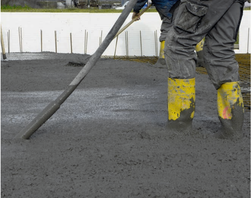
Abb. 9: Verdichten des Betons mit Rüttelflasche
