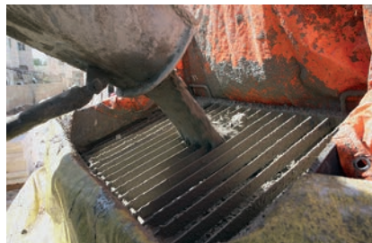
Abb. 20: Pumpen von hochfestem Beton der Druckfestigkeitsklasse C100/115
