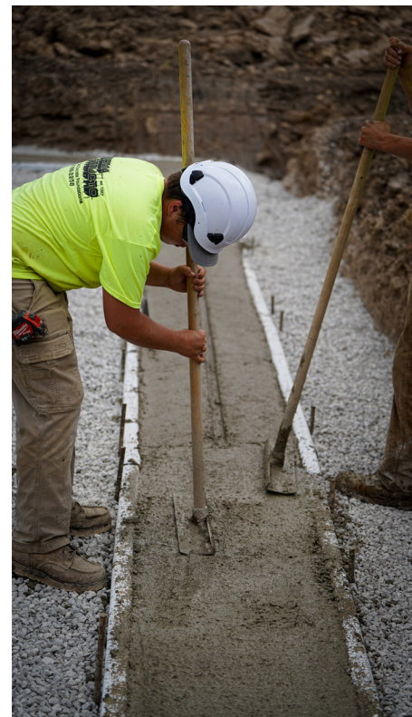
Un lycéen apprend à lisser le béton humide des fondations du logement
