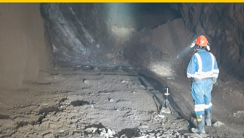
Avant (2022) : contrôle d'épaisseur
