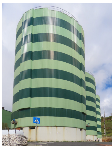
Tres torres de digestión
