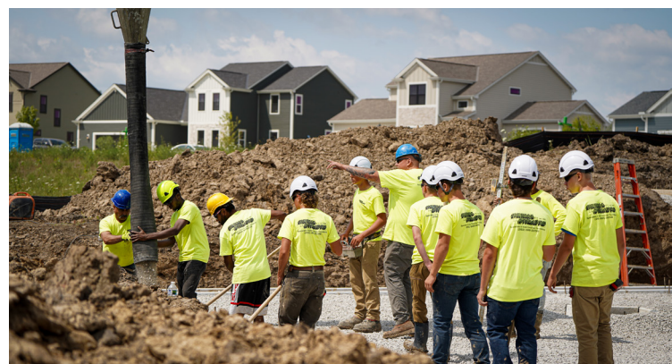
Un estudiante pone en marcha la Telebelt® 110 Putzmeister y otro supervisa que el hormigón se vierte correctamente bajo la supervisión de empleados de Perma-Structo
