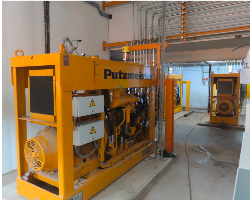
Equipo hidráulico HA 55 E de la tercera línea y los otros dos de fondo
